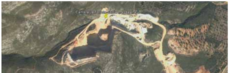
Imagen 1. Vista aérea de la cantera de Santa Magdalena. (Imagen obtenida de Google Earth: Google Earth 6.1. (2005). Cantera Santa Magdalena, 40°23'14.83"N 0°19'32.71"E, 1.32 km. -. Disponible de: Image © 2011 DigitalGlobe; © 2011 Tele Atlas)
